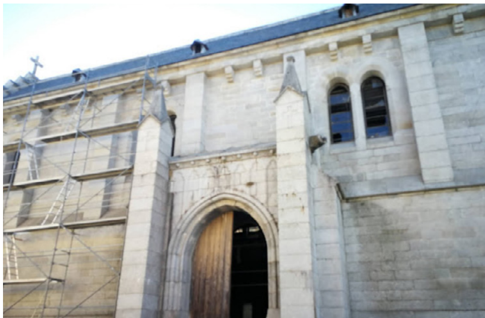
Figura 1. Fachada de la iglesia en la actualidad.
